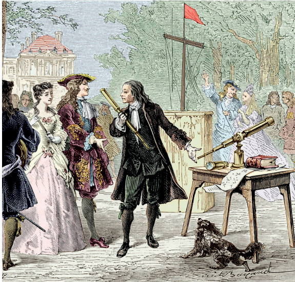
4. ábra. Amontons bemutatja az optikai távíróját a francia trónörökösnek a párizsi Luxemburg-kertben a 17. század végén. A távíróállomásokon elhelyezett mozgatható fakarok különböző állása felelt meg az ábécé betűinek. A távírász távcsővel olvasta le a jeleket (Alexis Belloc: La Telegraphie Historique, 1888)
